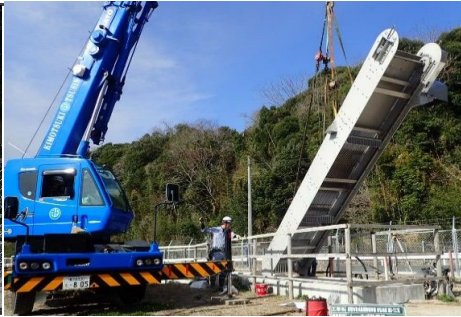
除塵機設備 製作・据付 (設置状況)
